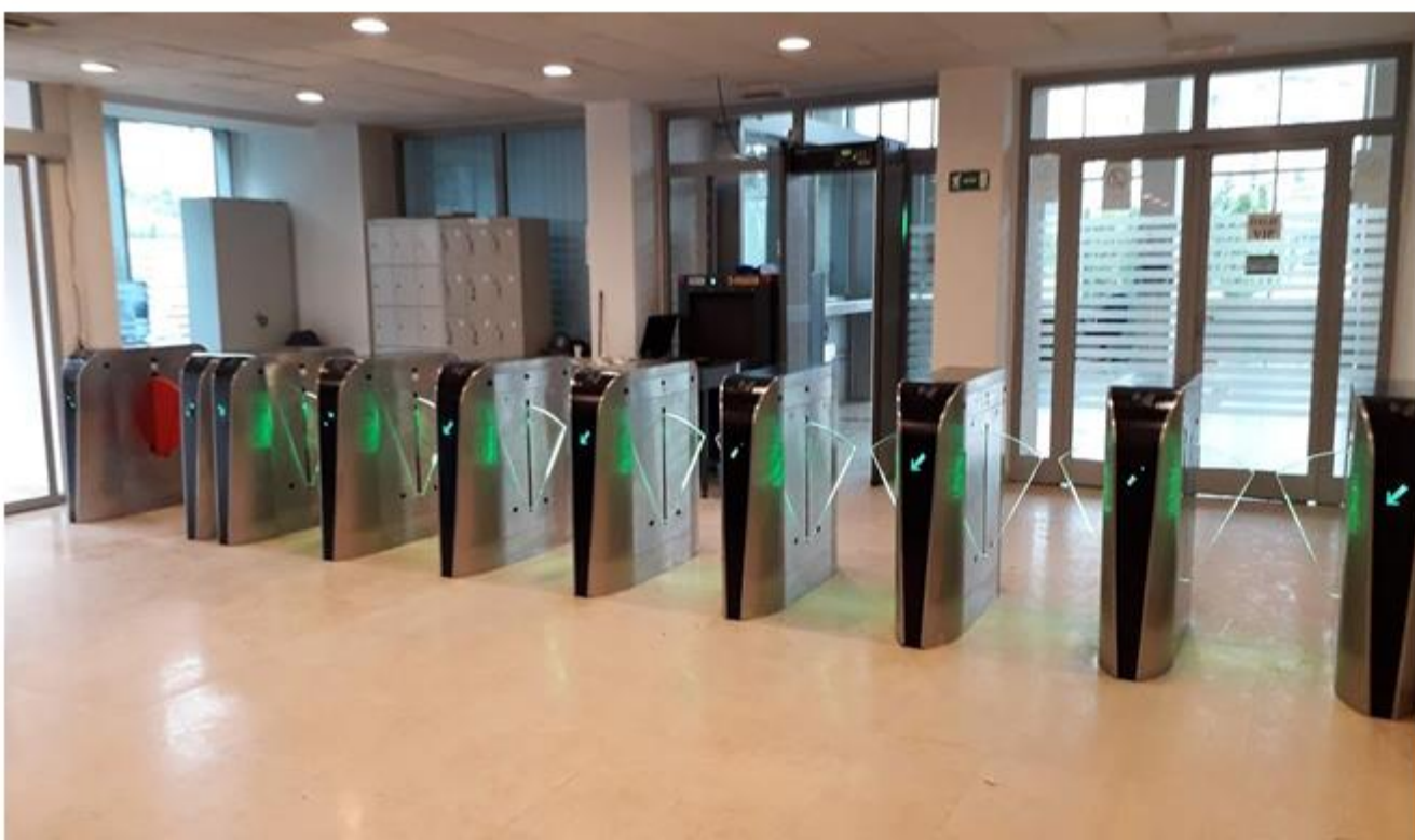
Furnizimi dhe montimi me akses control system përmes Flap Turnstile dhe UPS në objektin e Rilindjes
