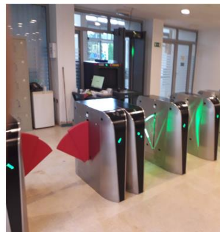
Furnizimi dhe montimi me akses control system përmes Flap Turnstile dhe UPS në objektin e Rilindjes
