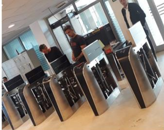
Furnizimi dhe montimi me akses control system përmes Flap Turnstile dhe UPS në objektin e Rilindjes
