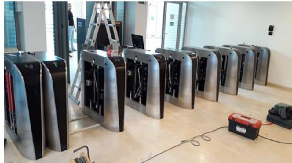
Furnizimi dhe montimi me akses control system përmes Flap Turnstile dhe UPS në objektin e Rilindjes
