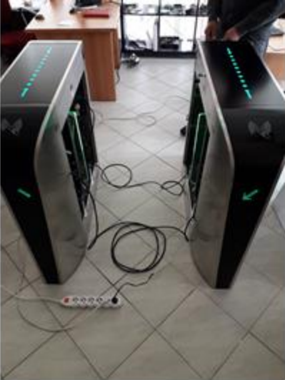
Furnizimi dhe montimi me akses control system përmes Flap Turnstile dhe UPS në objektin e Rilindjes
